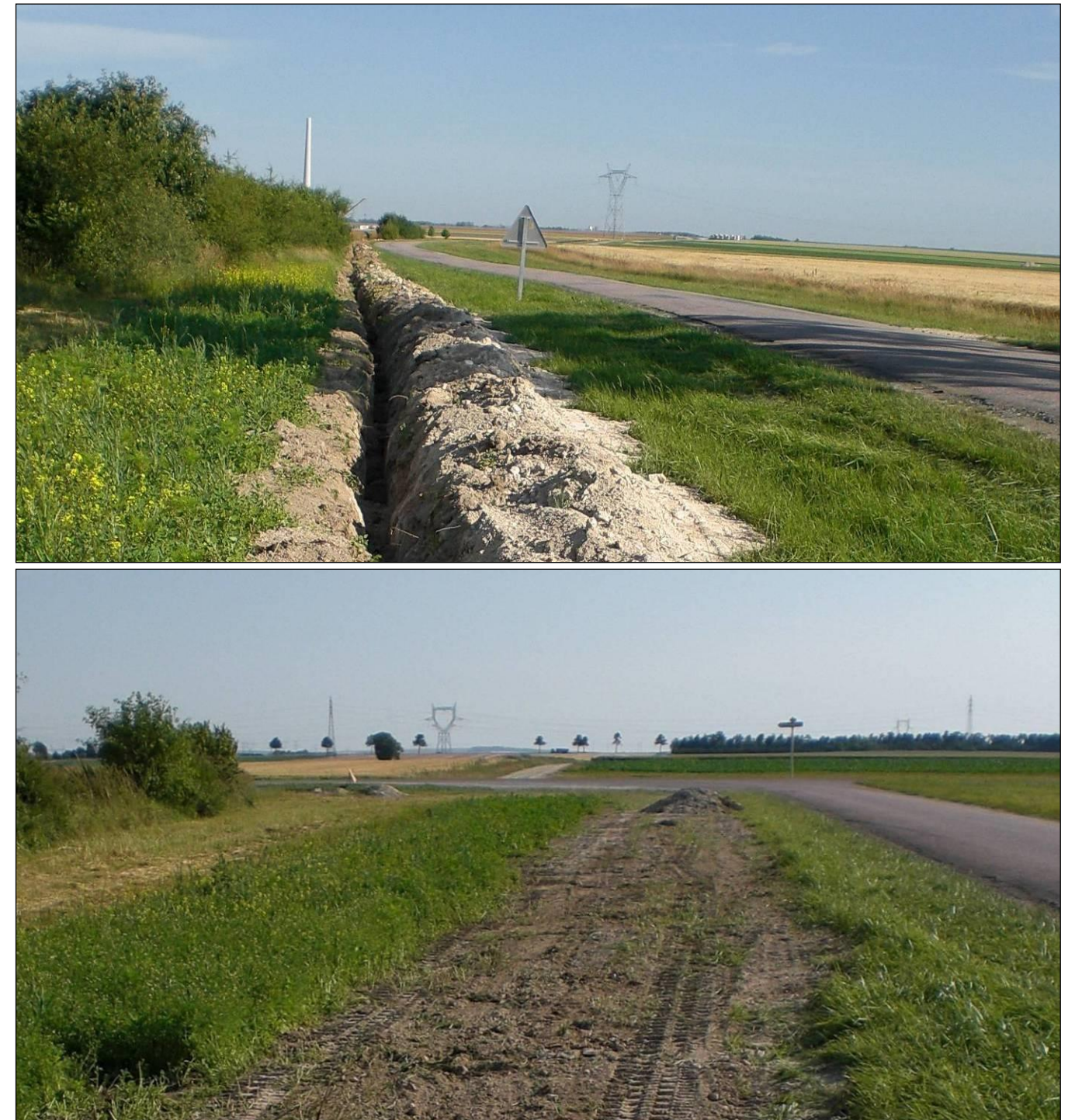
Photo 161 : Rebouchage de tranchée après passage des câbles électriques (Source : BE JC)
